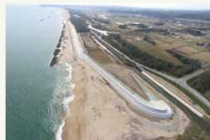
上空から見たがれきを活用した海岸堤防。「CSG」を使った海岸堤防は国内初です
