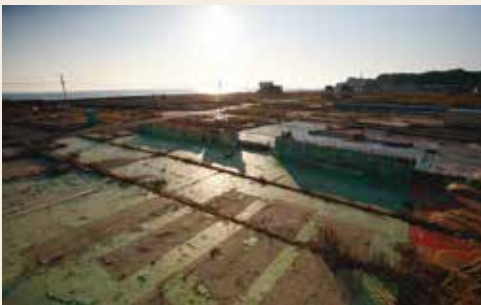
基礎撤去工事が始まり復興が進む薄磯地区。今年は新しい風景が見られることでしょう
