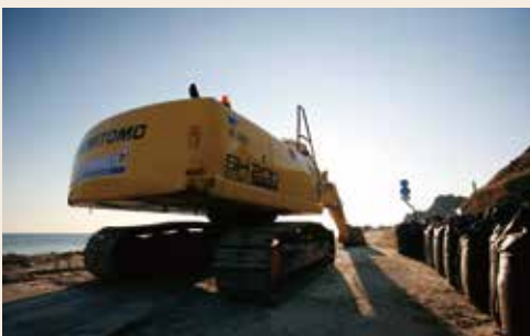
薄磯の堤防工事現場。復興の足音が聞こえてきます
